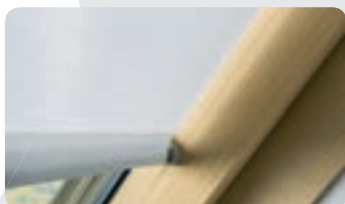
Фіксатор, який дозволяє фіксувати штору у трьох різних позиціях
