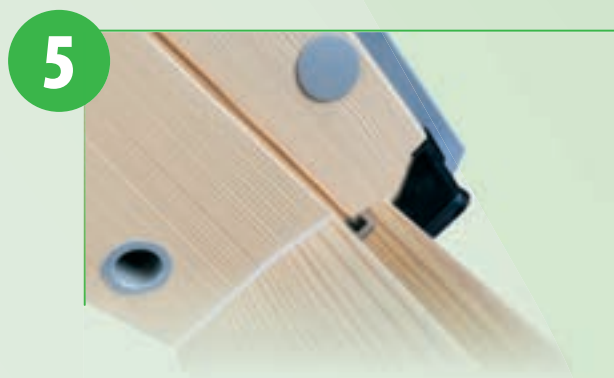
Захист кутових з'єднань рами та коробки вікна
